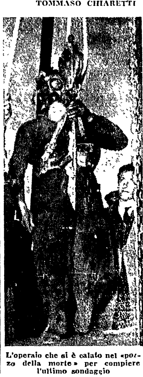
L'operaio che si è calato nel pozzo della morte per compiere l'ultimo sondaggio
